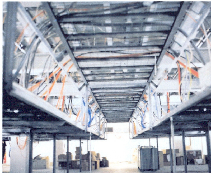
Das riesige Installationsgeschoß unter dem Serverraum. Hier liegen nur Kabel, die die Rechner vernetzen
